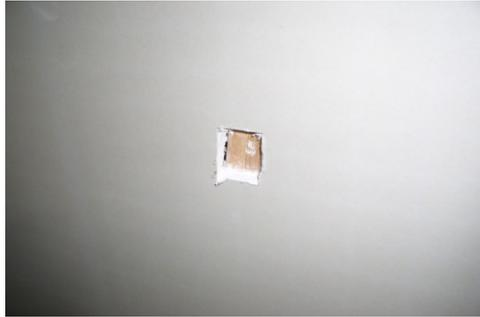
3. Dibujar el contorno de la Guía de instalación sobre la pared, verificando que la altura vertical sigue los requisitos indicados en la “Plantilla de montaje sobre pared” (30-S0003). Abrir la pared para que la Guía de instalación apoye directamente sobre el montante de madera.
