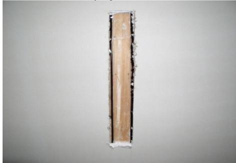
4. Colocar la Guía de instalación sobre el montante de madera. Si la superficie de la Guía de instalación queda por debajo de la superficie de la pared, se deberá utilizar un método de fijación más largo.
